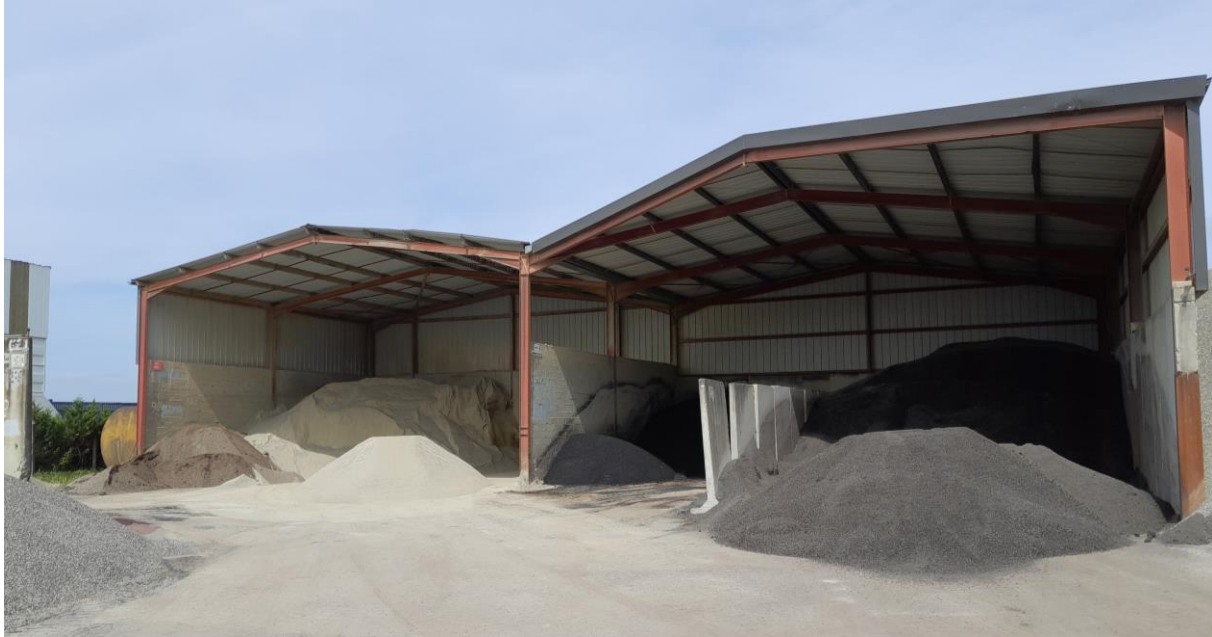
Figure 12 : Hangar de stockage des matériaux les plus fins (exemple)
